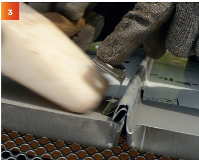
basse du clip, alignée sur la découpe du film. Sans ouvrir le Joint debout VMZINC®, insérer à la main le clip dans le Joint debout VMZINC®. Le faire rentrer dans le joint.
