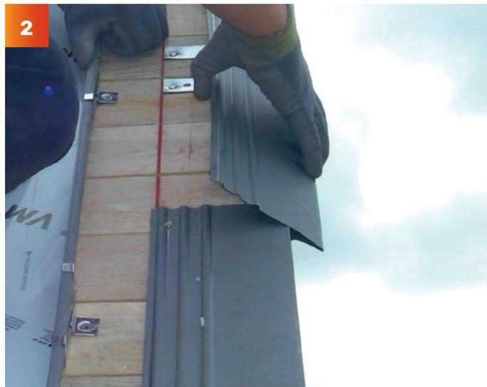
2 Accrocher le larmier de la bande de rive G3 aux raidisseurs et la fixer par clouage, comme pour la bande d'égout G3. Les éléments se superposent de 50 mm. La pose des bandes de rive se réalise de bas en haut.
