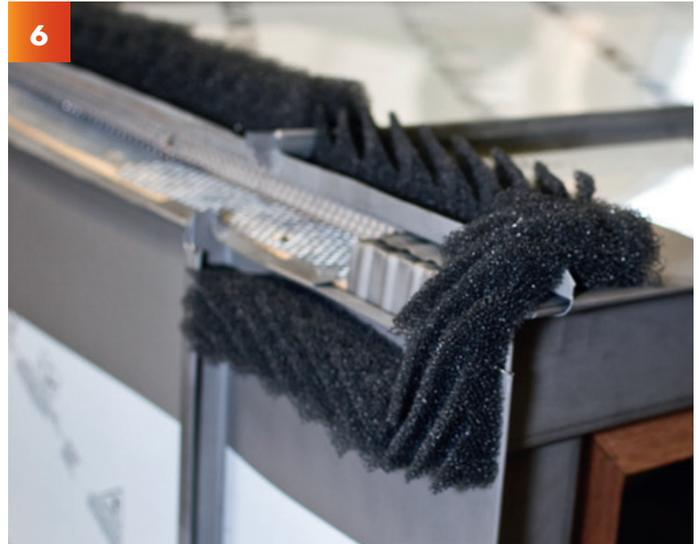
Afin d'assurer la continuité de l'étanchéité, bien presser les morceaux de bandes de décompression l'un contre l'autre. (maximum 1 joint par largeur de bande Joint debout VMZINC®). En rive, respecter la continuité de la bande de décompression.
