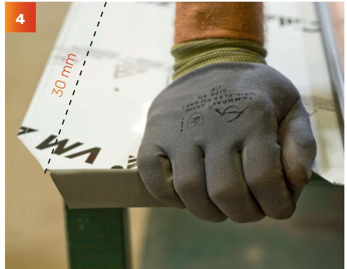
Plier le pied à 180° (hauteur du pli 30 mm) sur toute la largeur de la bande, plier le côté extérieur à 110° sur toute la longueur (hauteur du pli : 30 mm).
