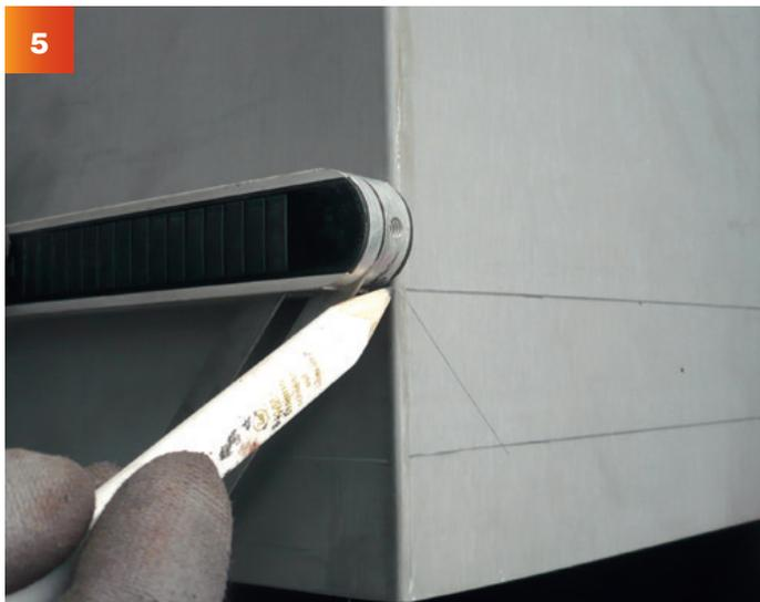
Tracer le "demi-angle du faîtage". Cet angle est tracé à partir de la ligne de 65 mm.
