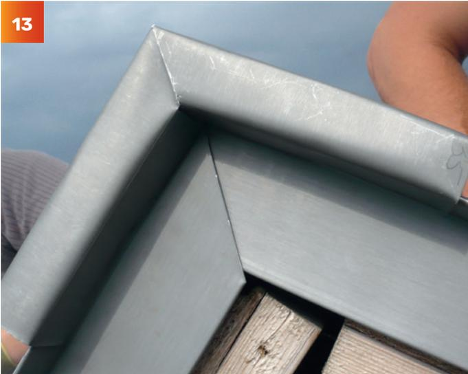
Pour fixer le faîtage G3, placer l'élément de faîtage G3 en accrochant le pli de retour sous la bande de rive G3.
