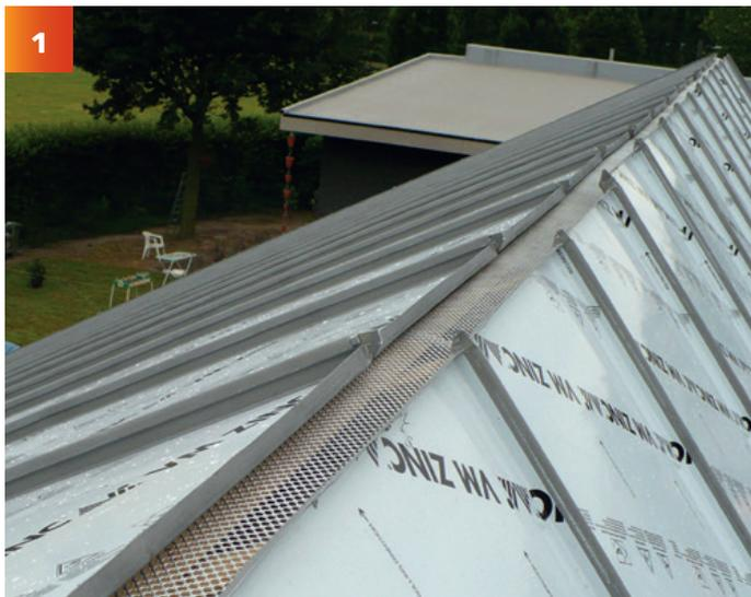
Commencer la pose du faîtage dès que l'ensemble des bandes Joint debout VMZINC® est posé et fermé par double sertissage.
