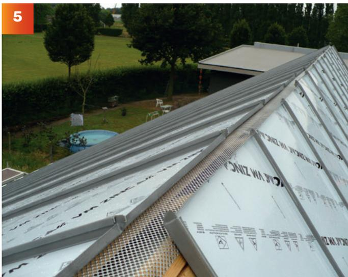
Dans le cas de toiture aérée : laisser un espace d'aération (35 mm mini), protégé par un treillis moustiquaire, entre les dernières voliges de chaque versant. L'espace entre les bandes de Joint debout VMZINC® de chaque versant de la toiture doit être égal à 30 mm.
