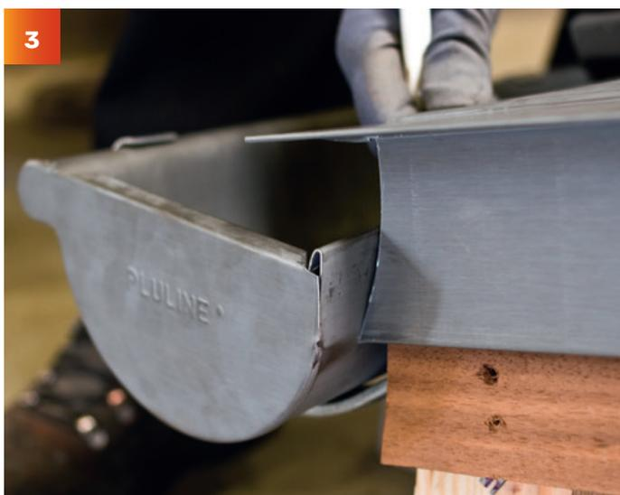
3 Pour obtenir un résultat parfaitement esthétique, il est conseillé de d'abord redresser le larmier de la bande de rive G3, à 90°. Le larmier de la première bande de rive G3 (à chaque angle inférieur de la couverture) doit être découpé en sa partie basse, pour épouser le profil de la gouttière utilisée.
