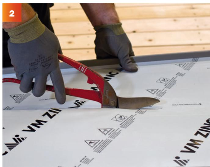
Calepiner la couverture de manière à obtenir des bandes de Joint debout VMZINC® en rive dont la largeur utile minimum est de 150 mm et de 370 mm maximum. En général un calepinage symétrique donne un meilleur résultat esthétique. Pour les toitures courbes, le rayon de cintrage doit être au minimum de 3 m. La pose des bandes commence soit au centre, soit à l'une des extrémités du bâtiment.
