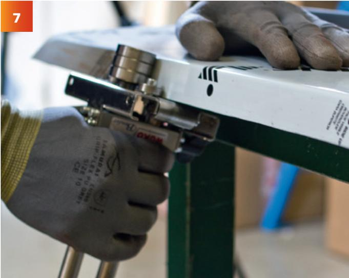
Après la pose des bandes de Joint debout VMZINC® de rive, replier la retombée côté extérieur sur le nez de la bande de rive G3. Terminer en serrant la pince sur la bande de rive G3, au moyen d'une pince à larmier.
