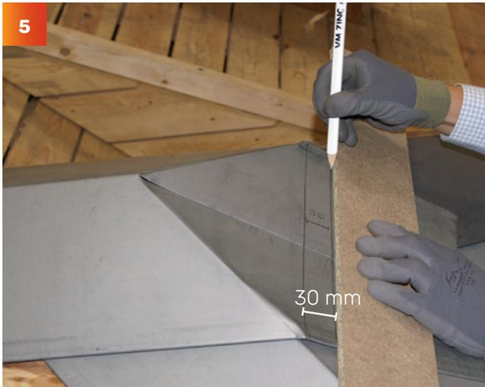
Sur la toiture (pour bien ajuster la finition de l'angle du capot), tracer une ligne horizontale 30 mm plus bas que les bords du capot, puis découper le long de cette ligne.
