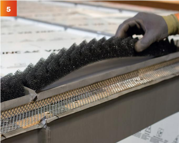
Coller la bande de décompression G3 en amont des clips à min. 10 mm du relevé de tête. Le zinc de VMZINC® doit être sec et dépolvérisé avant la pose de bandes de décompression G3. Longueur de chaque bande de décompression = largeur de la bande + 20 mm. Il est autorisé de récupérer les chutes de longueur supérieure à 150 mm.
