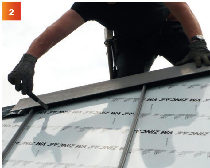
Positionner correctement un élément de faîtage sur l'axe de la toiture, sans le fixer. Découper légèrement au cutter le film de protection des bandes Joint debout VMZINC® en tête, des deux côtés du faîtage et le rentrer.
