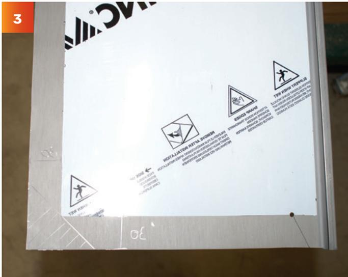
Tracer et retirer le film de protection sur 30 mm en pied et sur le côté non profilé. Au pied de la bande Joint debout VMZINC®, découper le coin extérieur à 45° (30/30 mm), réaliser la découpe oblique près du côté profilé.
