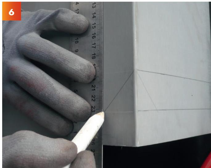
Au croisement entre cette ligne oblique (demi-angle du faîtage) et la ligne à 30 mm, tracer une ligne perpendiculaire jusqu'au bord du faîtage.
