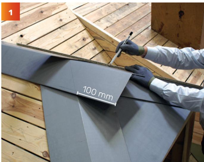
1 Couper un élément de faîtage G3 (longueur restant à couvrir + 100 mm au-delà des arêtiers). Poser l'élément de faîtage G3, sans le fixer. De part et d'autre du faîtage, tracer la ligne d'alignement avec les arêtiers.
