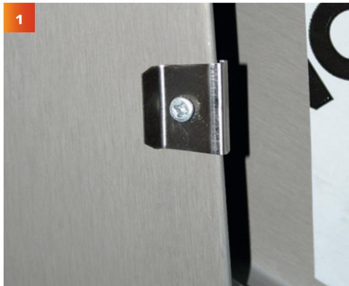
Pour éviter le glissement des arêtiers G3, vissez solidement en un seul passage dans chaque clip, à l'aide d'une vis en acier inoxydable type SPS 3-7, 1-4.5 x 18 mm de SFS ou équivalent. Utiliser un bit numéro SR1.
